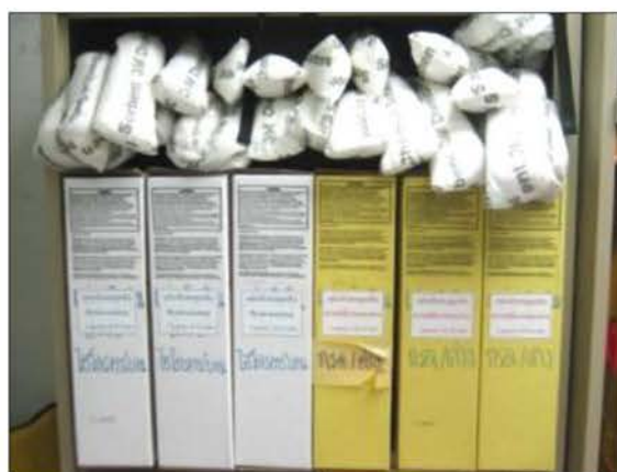
เรซินดูดซับสารเคมี (ไฮโดรคาร์บอน/กรด-ต่าง)
